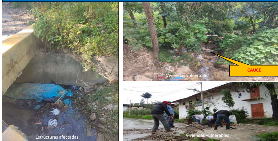
Fig. 01,02,03: Cauce Qda Shiragpampa. Tramo crítico. Cauce de la quebrada, produciendo asentamiento y desplazamiento en las pistas afectando bienes publicos, tambien en un suceso de lluvia intensa, la quebrada va a desbordar afectando a la vivienda en ambas márgenes, estructuras actuales han colapsado y no fueron diseñadas considerando el caudal maximo
